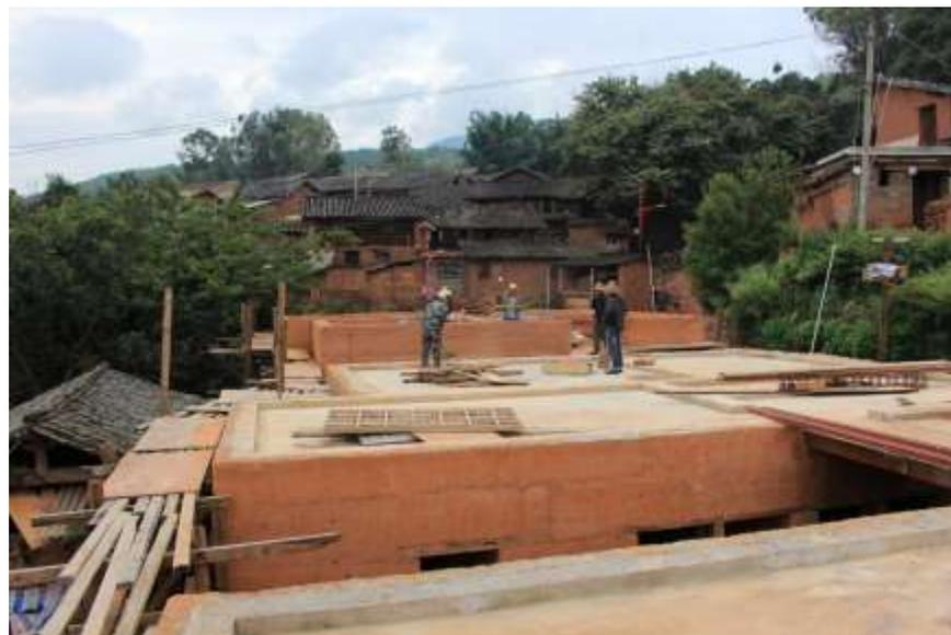
工匠們分工合作將樓板支撐支架拆除下來，并拔出固定用的釘子，確保安全施工環境；大擺依本村工匠負責將樓面場地清理乾淨
